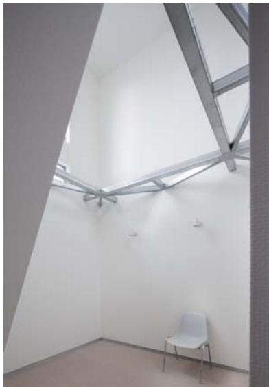
亜鉛メッキ鋼板の軽量鉄骨を室内装飾として配した吹き抜け。上下階の空間をつなぐ。
